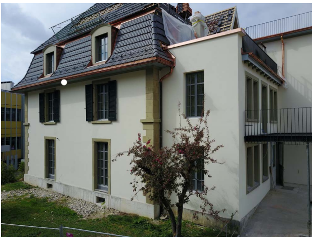
Nord-Ost Fassade mit neuem Balkon
