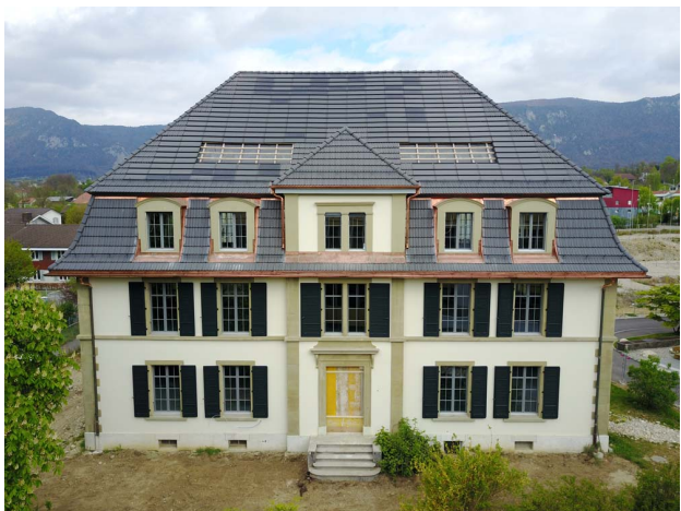
Fassade gegen Süden mit den Ausschnitten für die neuen Dachflächenfenster
