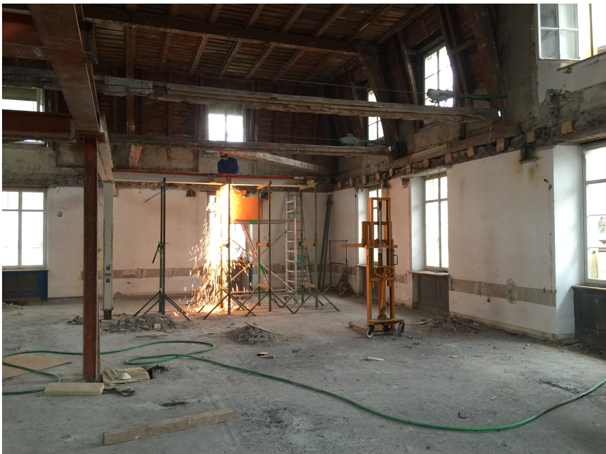
Rückbau der Geschosdecke OG/MG und anschliessendes Einbringen einer Betondecke
